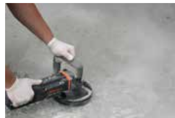
1. Preparación del substrato
