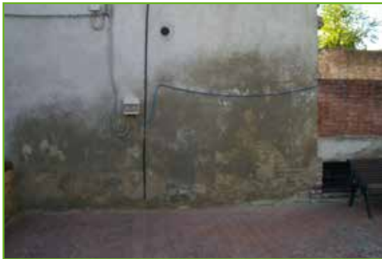
Cambio de color, reducción del aislante térmico
