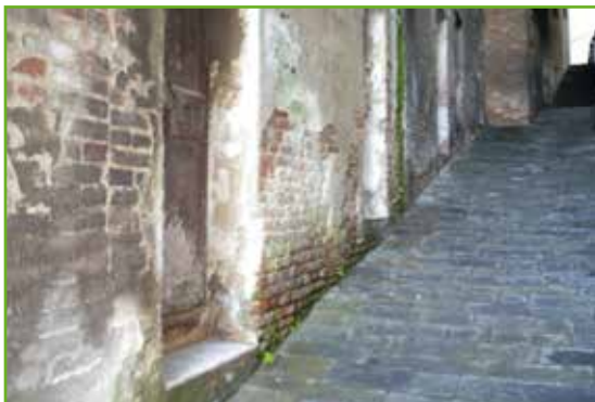
Dstrucción del yeso y las juntas de mortero
